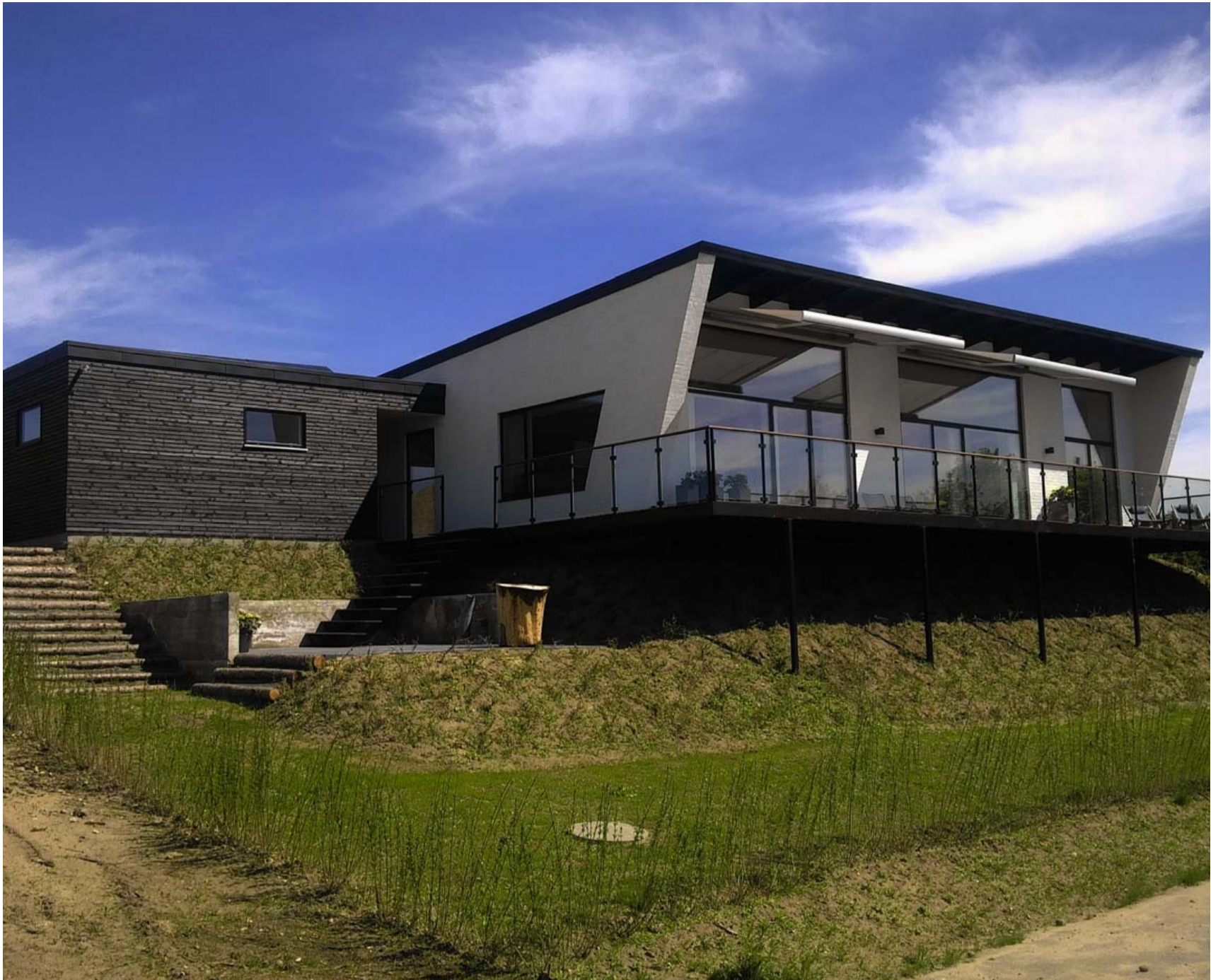
Huset i Silkeborg leverer strøm til beboerne via solceller monteret på carporten. FOTO: PR
