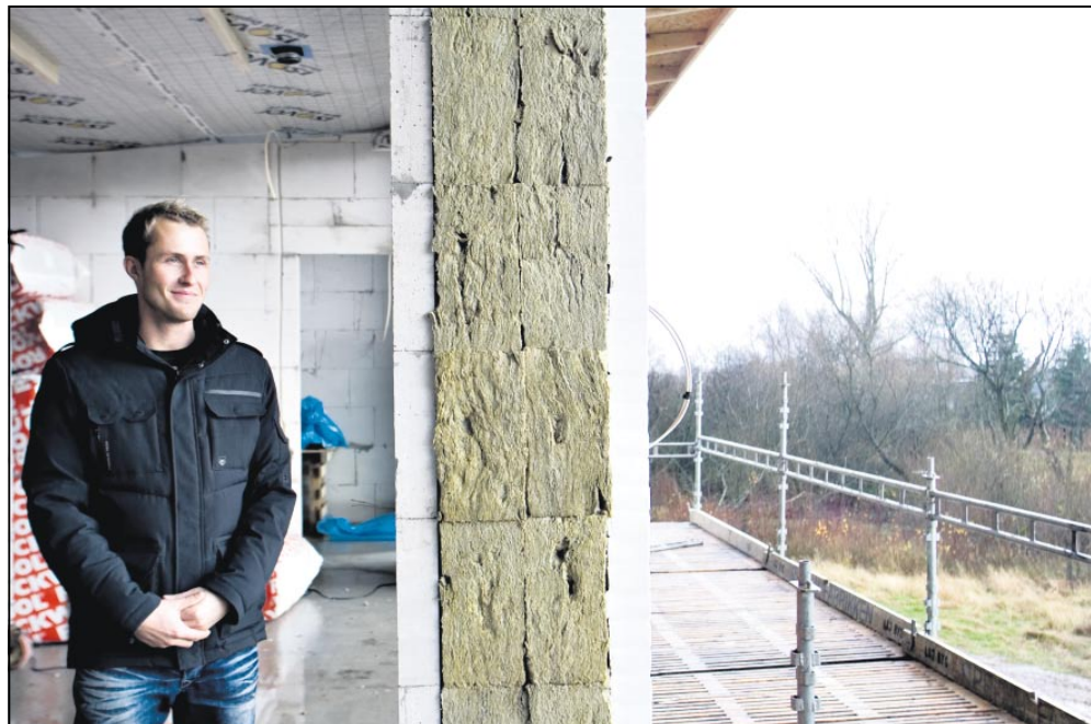
Et certificeret passivhus har et meget lavt energiforbrug. Det opnås blandt andet gennem øget isolering. 450 millimeter i gulvet 600 millimeter på loftet og - som det ses her - 400 millimeter i ydervæggene.
